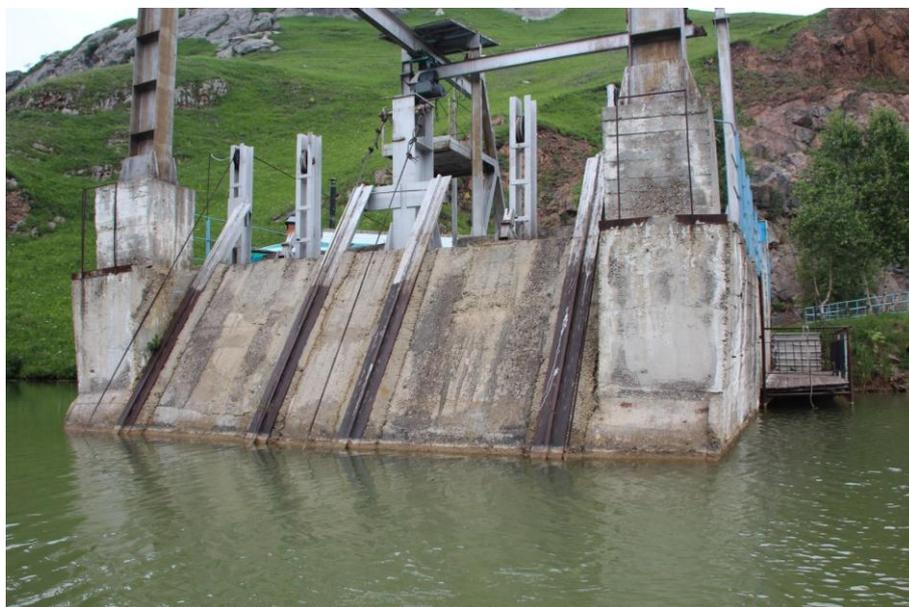
Рисунок 1 - Наклонная галерея водозаборного сооружения Эшкаконского гидроузла
